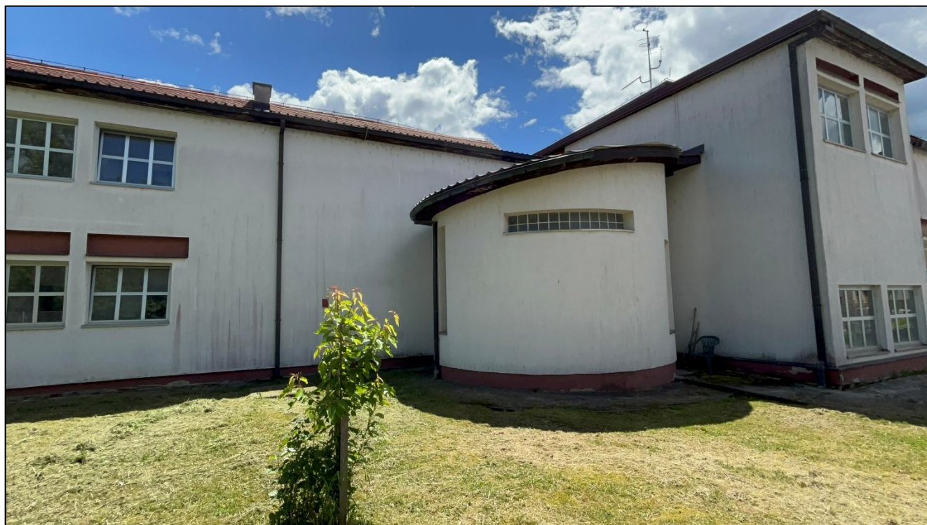
Slika 12: Sjeverozapadno pročelje – vanjska strana
