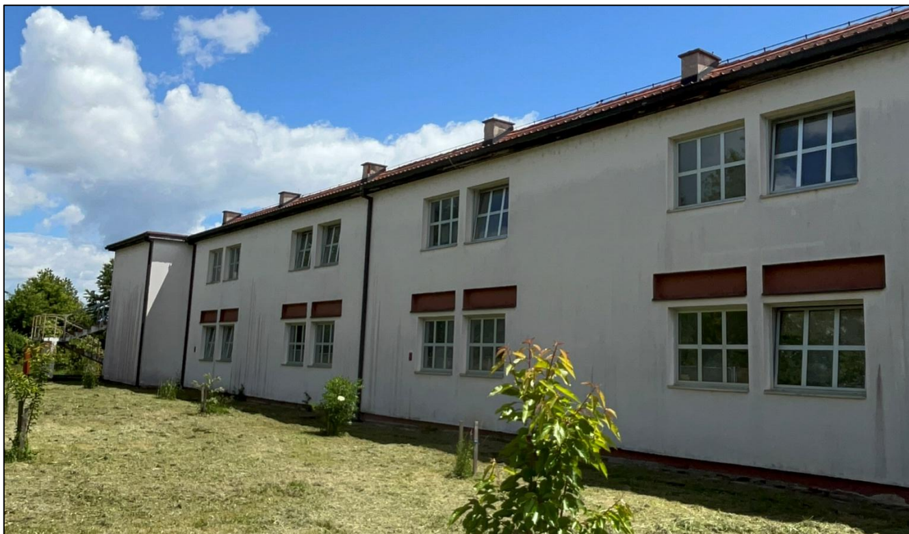
Slika 11: Sjeverozapadno pročelje – vanjska strana
